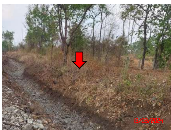
รูปที่ 11 คั่นทำนบดินและแนวต้นไม้บนคันทำนบดิน
